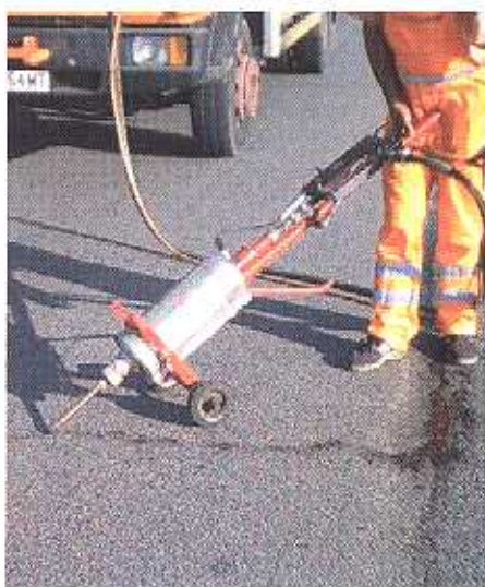
Почистване и подготовка на фугата
