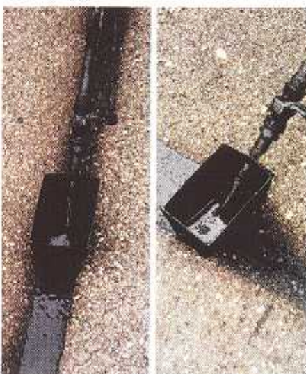
Заливане на пукнатини или фуги
