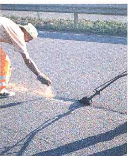
Запълване и стабилизиране с фракция
